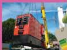
Installation de la chaudière bois sur le secteur Bretagne
